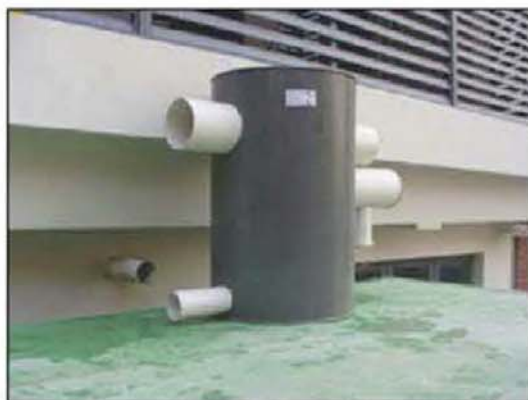
图A9-16 机械式雨水弃流装置示意图
