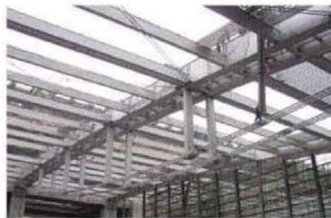
图D4-6 钢结构预应力技术-张弦梁结构
