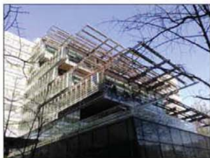
图E8-16 光伏与遮阳一体化实例
