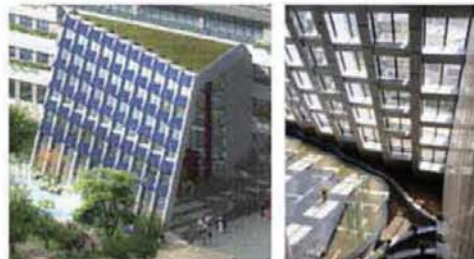
图F1-5 光电板遮阳室内外示意图
