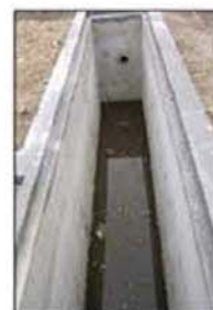
图D6-3 用再生混凝土建造的污水处理设施
