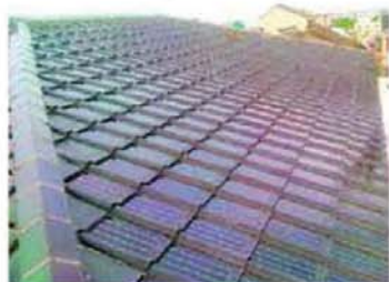
图B11-2 太阳能电池瓦
