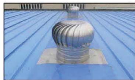
图E10-21 旋流型自然通风器示意图
