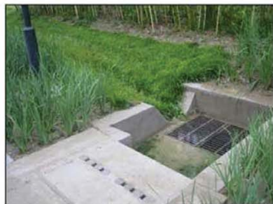
图A9-17 明沟接入沉砂池示意图
