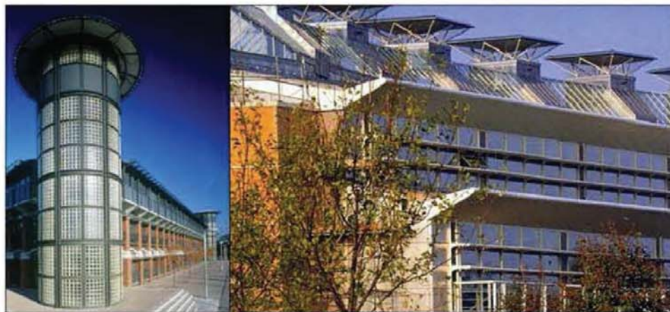
图E10-10 利用楼梯间及中庭的烟囱效应拔风的应用实例
