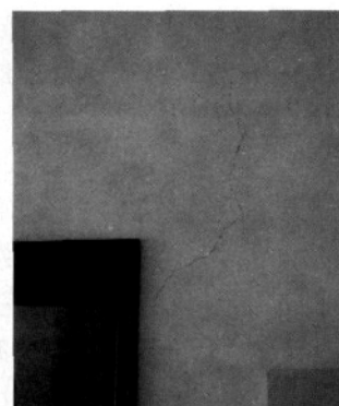
图 3 门洞口斜裂缝
