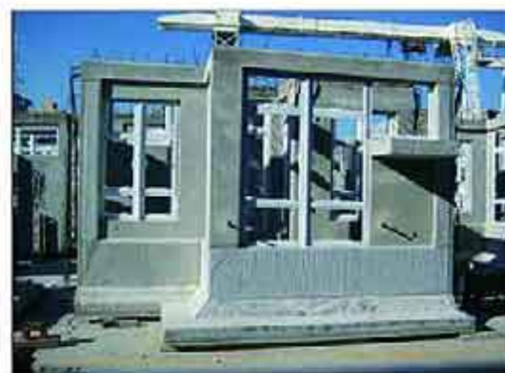
转角窗台外墙
