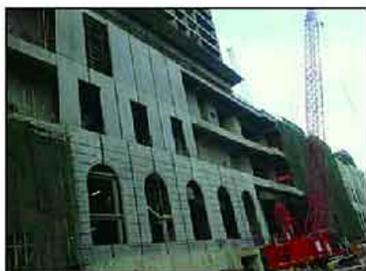
外挂墙工地现场
