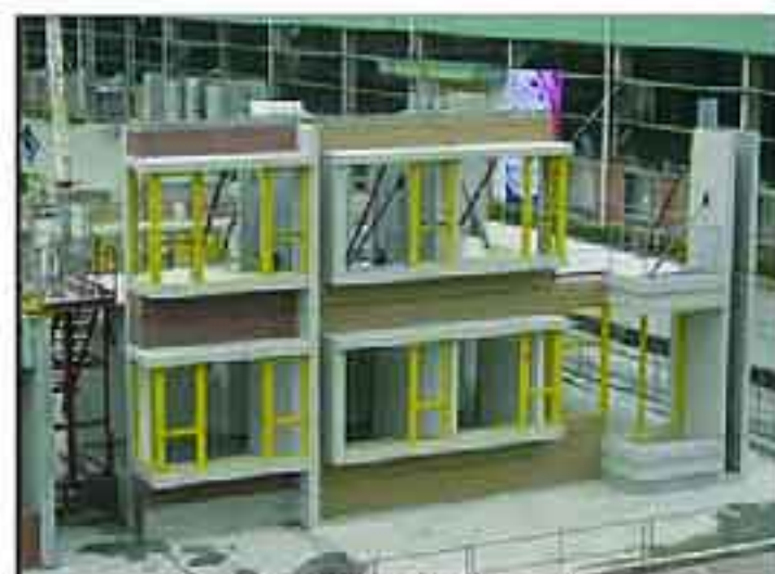
窗台外墙样板房安装
