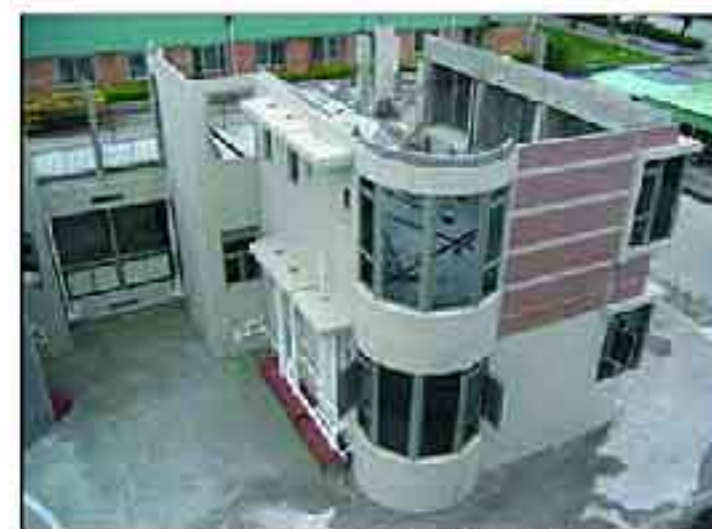
弧形窗台外墙样板房
