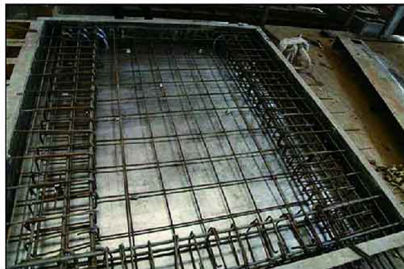
预制墙板内置钢筋局部（二）
