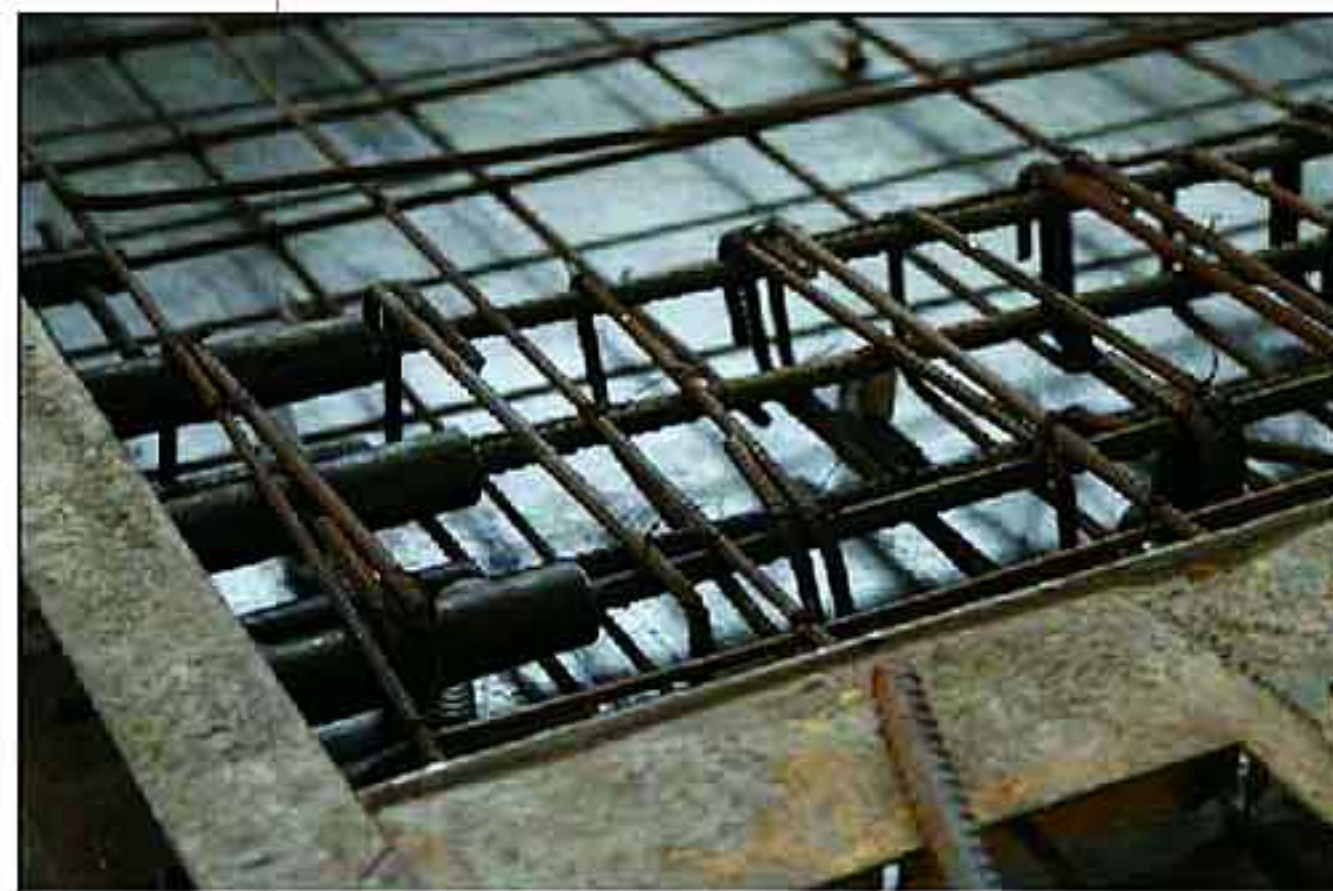
预制墙板内置钢筋局部（一）
