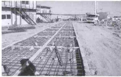
图2 临时道路板支模及绑扎钢筋情况
