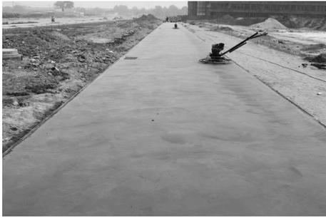
图2 现浇混凝土路
