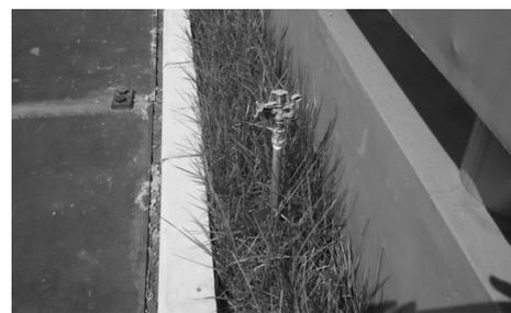
图4 循环水喷洒系统安装
